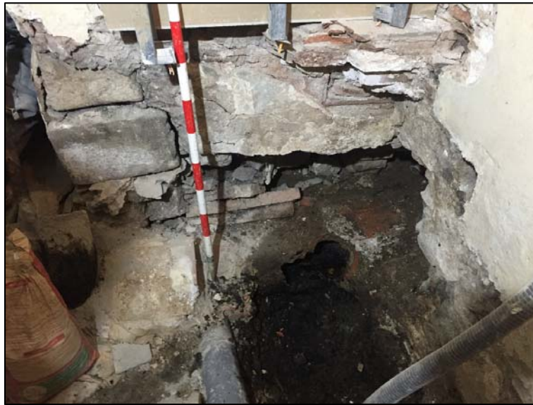
Fig. 21. Inici dels treballs de substitució del col·lector (UE 35) a sota l'escala.
