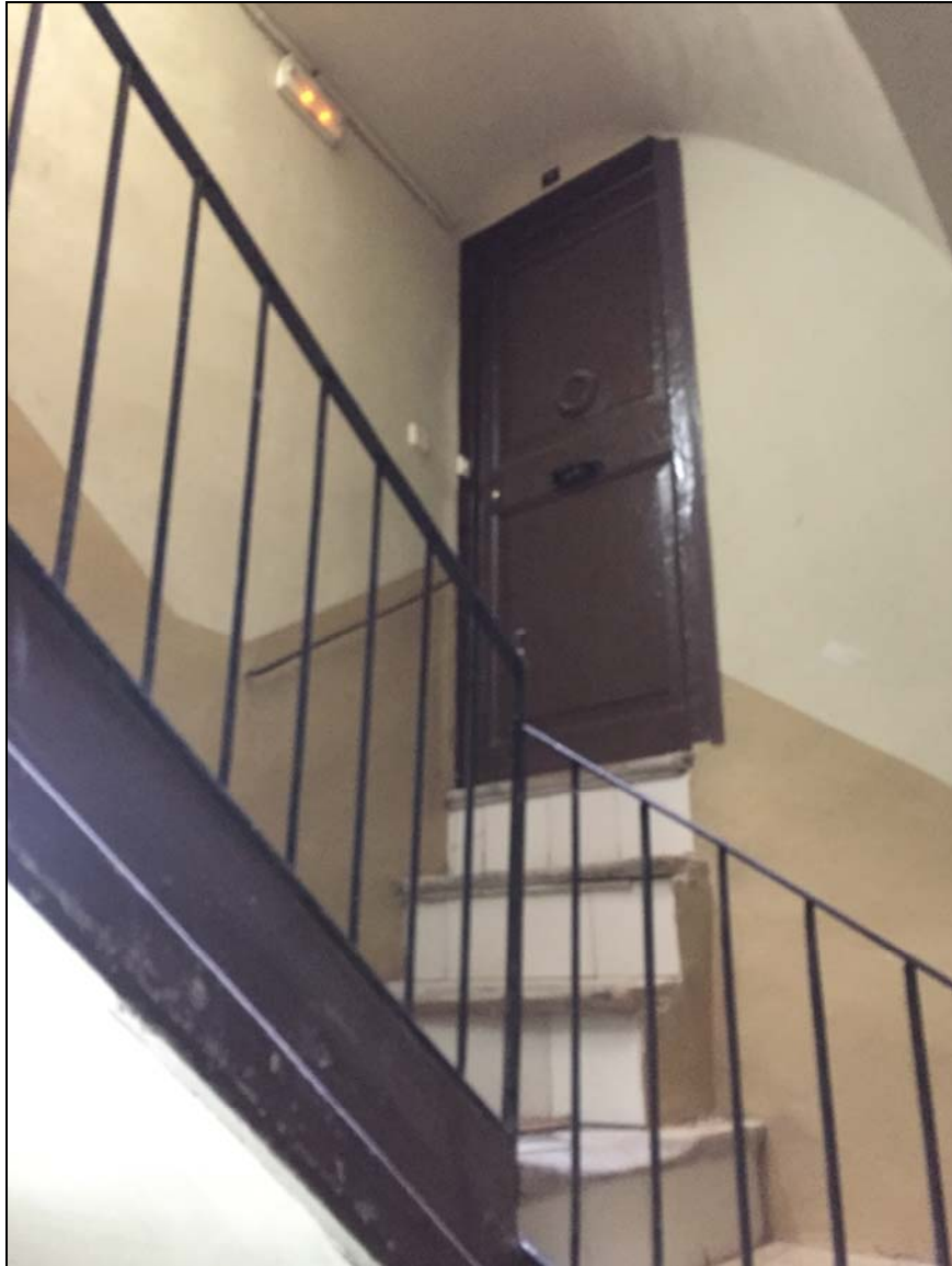
Fig. 26. Replà del quart pis on s'aprecia el gruix del mur entre les finques 33 i 35.
