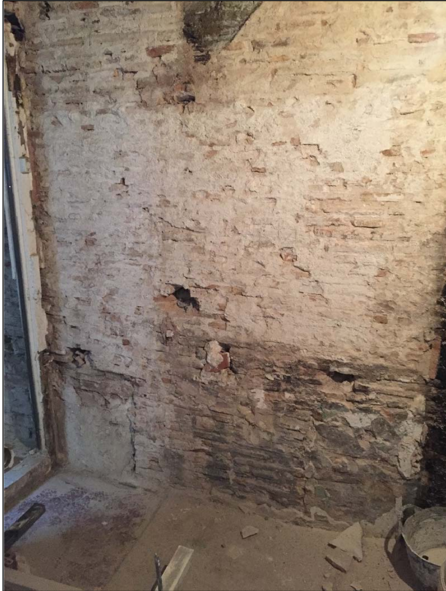
Fig. 30. Mur de maó de mida petita i argamassa de bona factura. Quarta planta de la finca del carrer de la Palla, 33-35.
