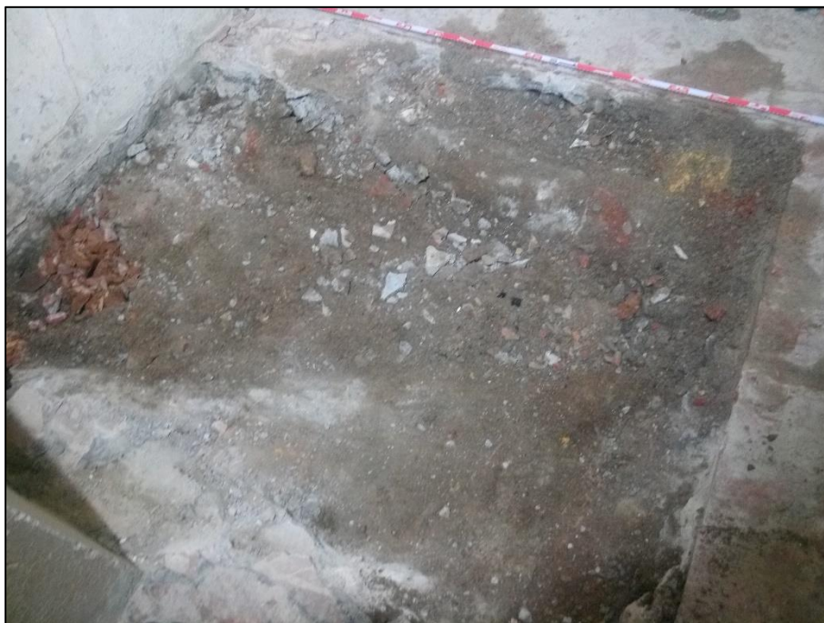
Fig. 4. Espai del forat d'ascensor amb el nivell d'enderroc a la vista (UE 5).
