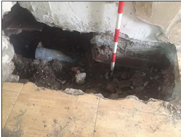
Fig. 23. Punt en què el col·lector (UE 35) passa per sota del mut mitger entre el local i l'accés a l'escala.
