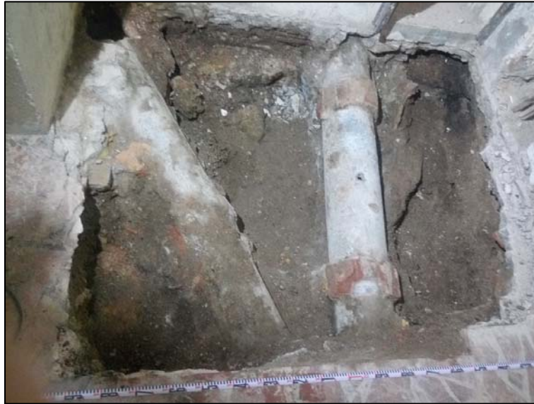
Fig. 3. Clavegueres (UE 3 i 4) que convergeixen en el col·lector situat sota l'escala.
