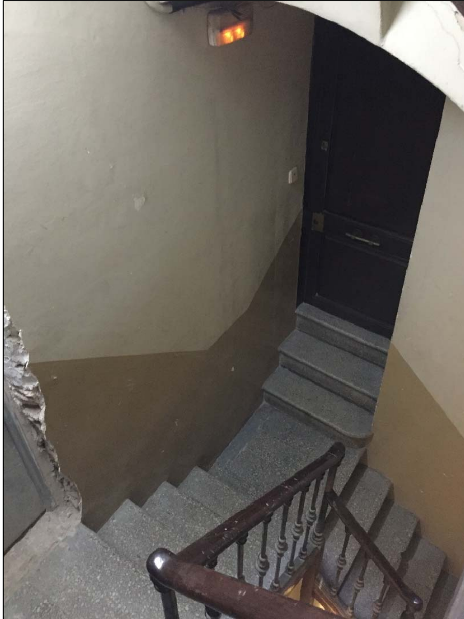
Fig. 25. Replà del primer pis on s'aprecia el gruix del mur entre les finques 33 i 35.
