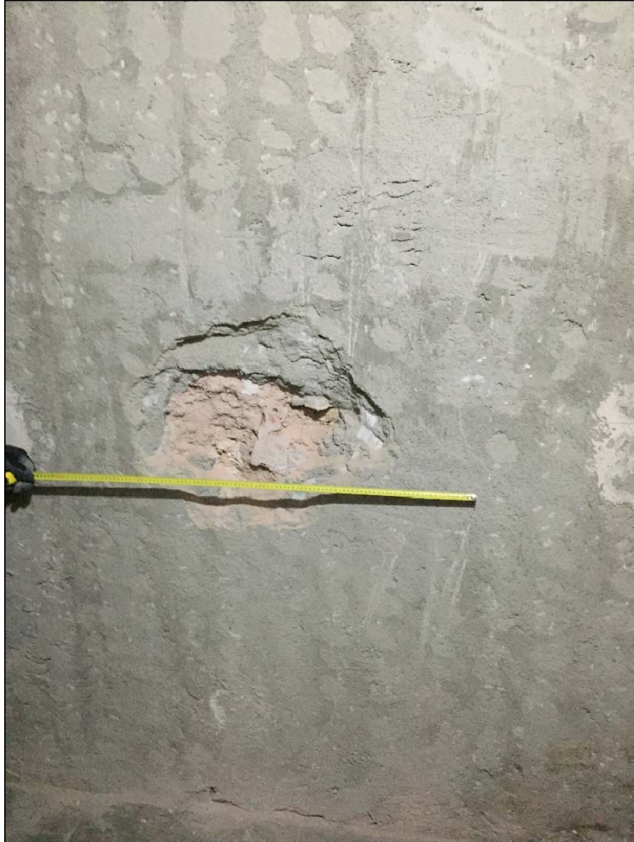
Fig. 27. Petit sondeig en el mur que separa les dues antigues finques números 33 i 35 del carrer de la Palla. Planta primera.
