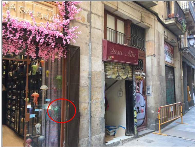
Fig. 1. Vista de la façana de la finca núm. 33-35 del carrer de la Palla.
