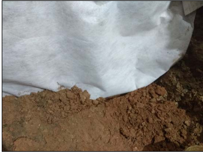
Fig. 14. MR 24, cobert amb geotèxtil abans de realitzar la sabata de formigó del fossat d'ascensor.
