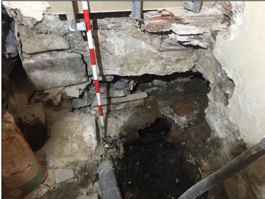
Fig. 17. Inici dels treballs de substitució del col·lector (UE 28) a sota l'escala.
