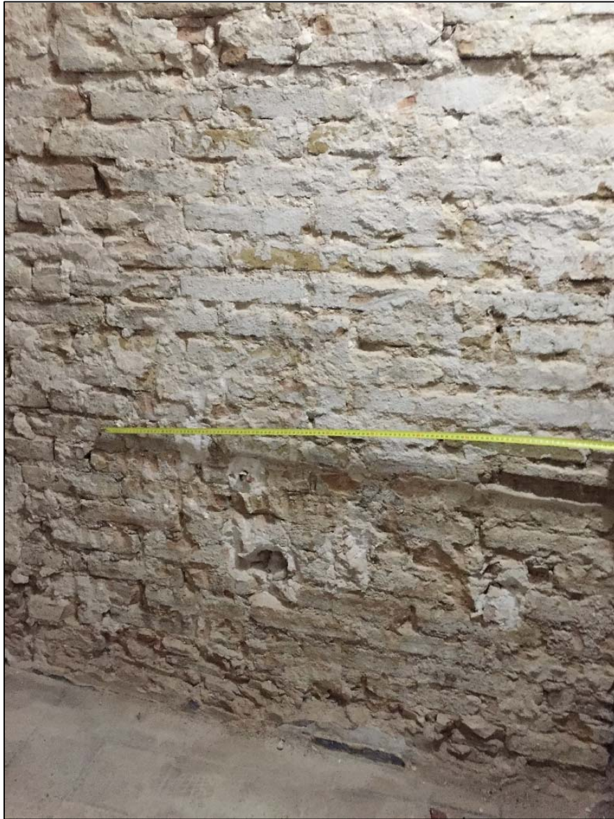
Fig. 29. Mur de maó de diverses mides i argamassa de bona factura. Tercera planta de la finca del carrer de la Palla 33-35.
