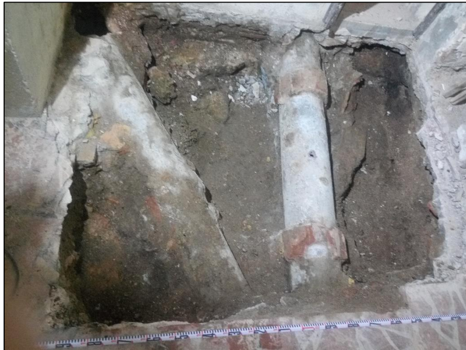
Fig. 5. Clavegueres (UE 3 i 4) que convergeixen en el col·lector situat sota l'escala.
