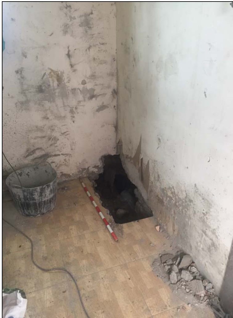
Fig. 22. Punt en què el col·lector (UE 35) passa per sota del mur mitger entre el local i l'accés a l'escala.
