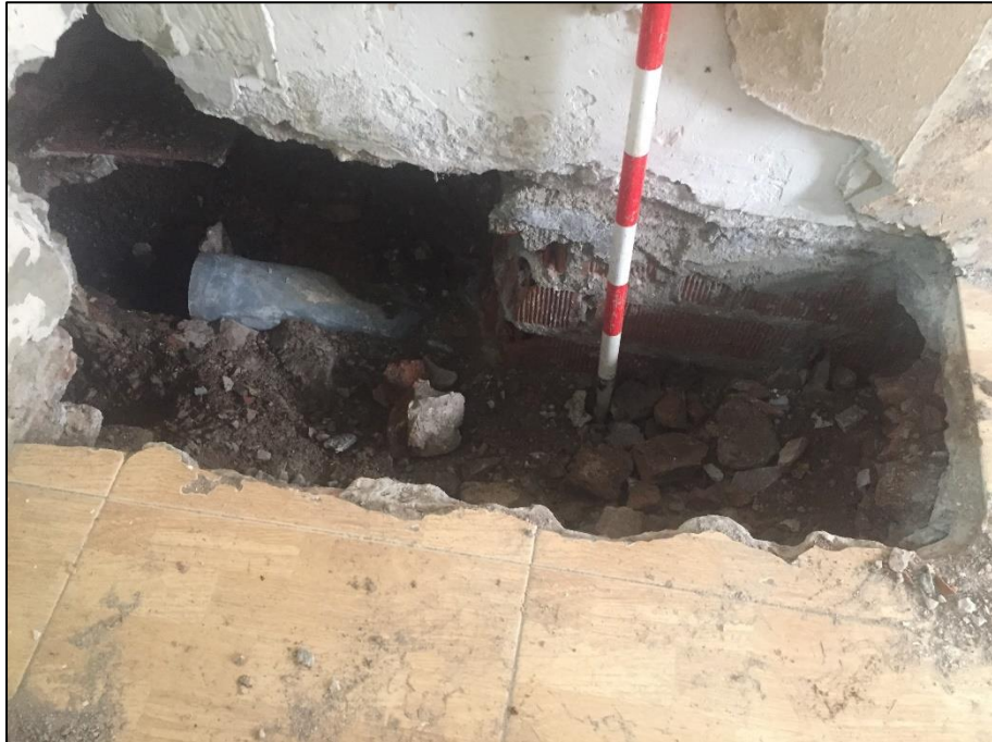
Fig. 18. Punt en què el col·lector (UE 28) passa per sota del mut mitjaner entre el local i l'accés a l'escala.
