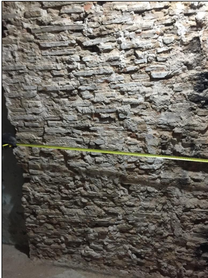
Fig. 21. Mur de maó de mida petita i argamassa, de factura irregular, en la segona planta de la finca del carrer de la Palla, 33-35.
