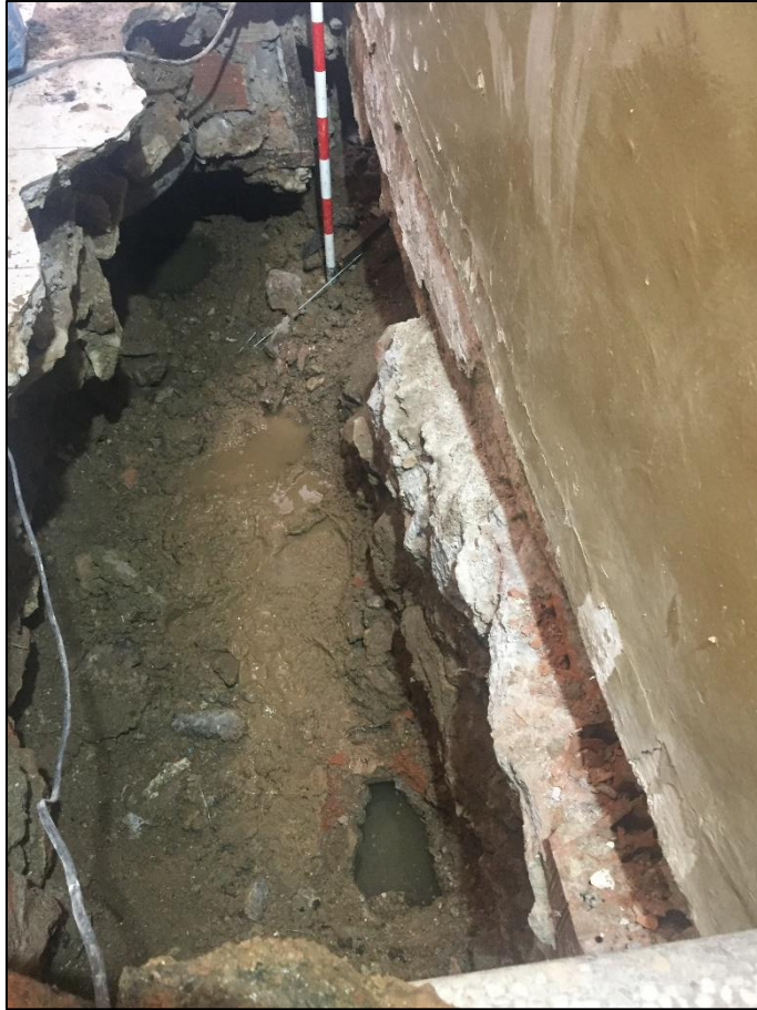
Fig. 19. Punt en què el col·lector (UE 28) es prolonga per la zona d'accés a l'escala o vestíbul fins a la façana de l'edifici.
