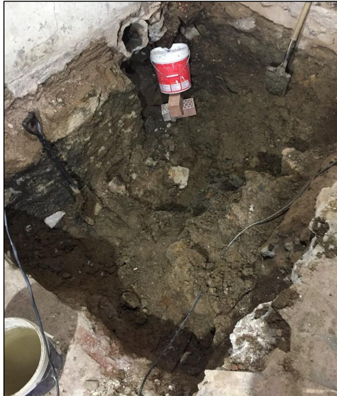
Fig. 11. Vista del fossat un cop excavada la UE 15 i on també s'ha excavat parcialment la UE 17. S'observa el nivell d'enderroc o preparació de la UE 16 al costat est, així com els murs UE 19 i 21 i el que s'ha interpretat com la seva rasa de fonamentació (UE 20).
