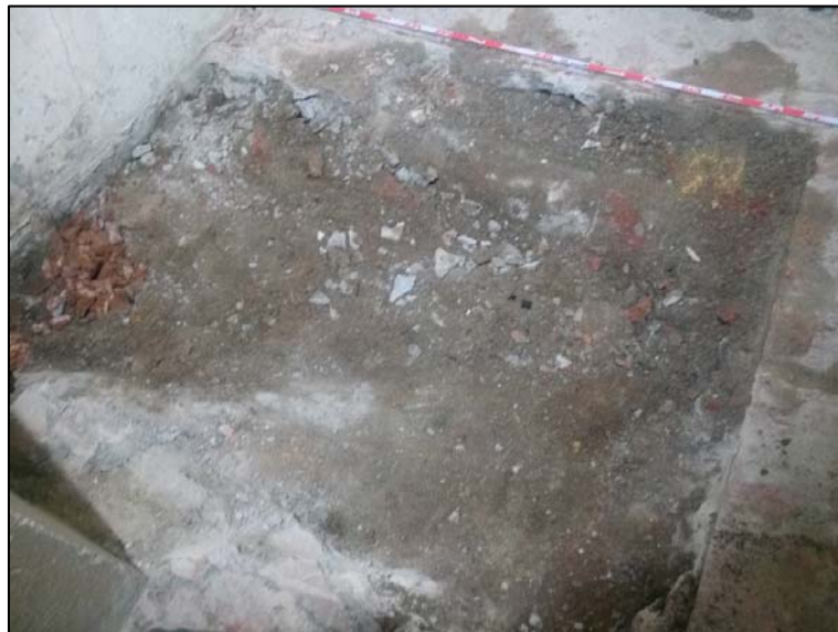
Fig. 2. Espai del forat d'ascensor amb el nivell d'enderroc a la vista (UE 5).
