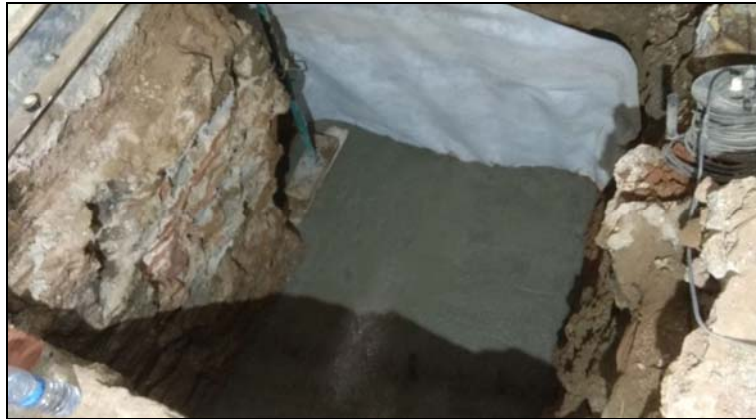
Fig. 15. Sabata de formigó del forat de l'ascensor amb el geotèxtil que cobreix el mur (UE 24).
