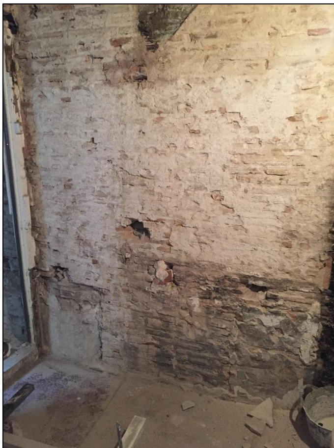
Fig. 22. Mur de maó de mida petita i argamassa de bona factura en la quarta planta de la finca del carrer de la Palla 33-35.
