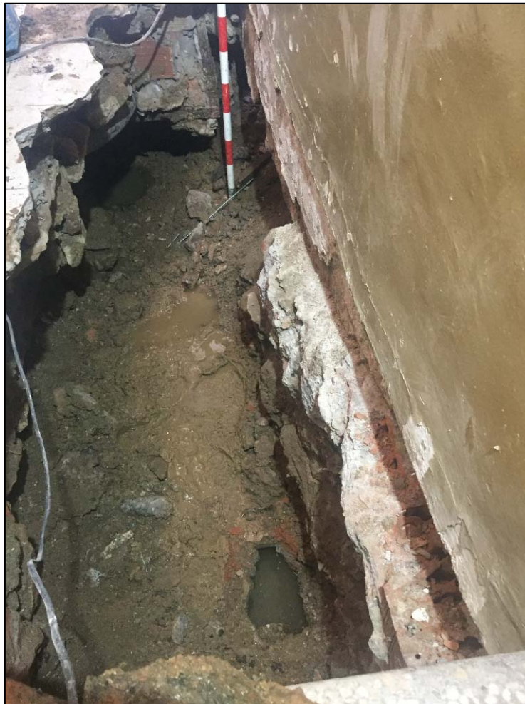
Fig. 24. Punt en què el col·lector (UE 35) es prolonga per la zona d'accés a l'escala o vestíbul fins a la façana de l'edifici.
